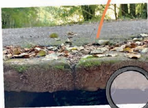
Cheniménil / Jarménil : réfection dans son intégralité d'un aqueduc.
