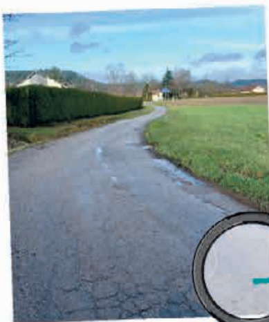
Fays/Lépanges-sur-Vologne : réfection de l'intégralité de la chaussée, curage et dérasement des fossés et mise à niveau des accotements
