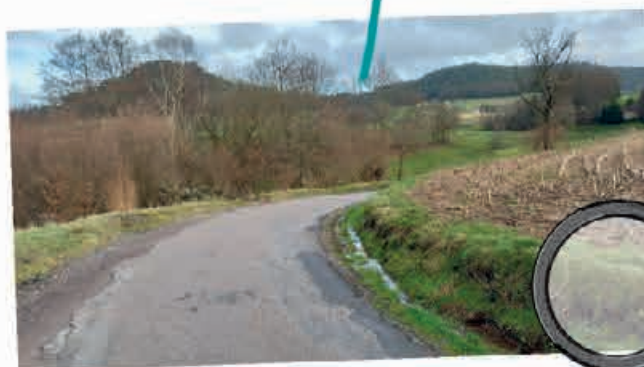
La Neuveville-devant-Lépanges / Le Boulay : réfection de l'intégralité de la voie, gestion des eaux pluviales, drainage du fossé, réfection de l'enrobé et implantation d'une chicane afin de réduire la vitesse.
